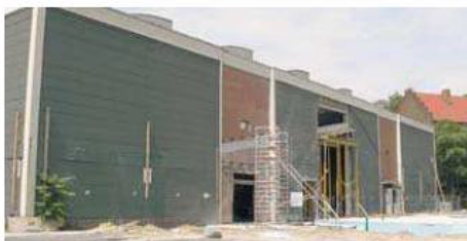
Die Halle des Blumengroßmarkts wird zum Standort des Jüdischen Museums umgebaut. Für das Gelände um das Gebäude läuft seit 15. Juli eine Ausschreibungsverfahren. Foto: Frey
